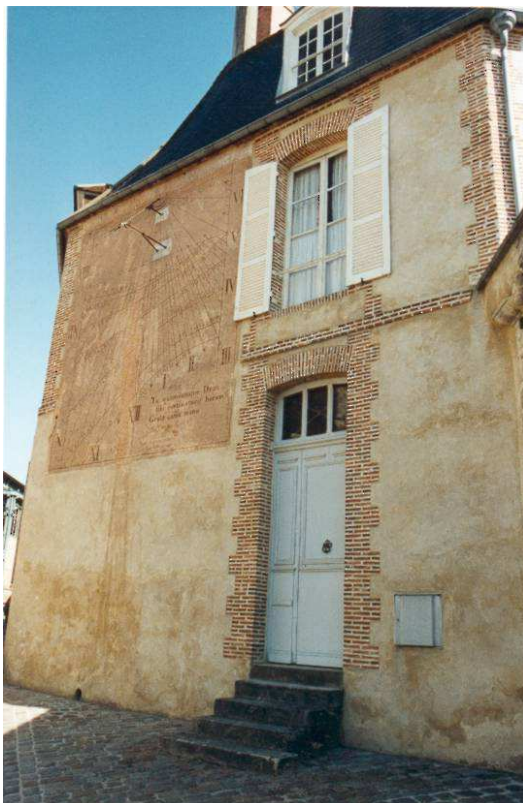
Vue générale de la façade
